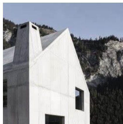
Architetture di Caminada
